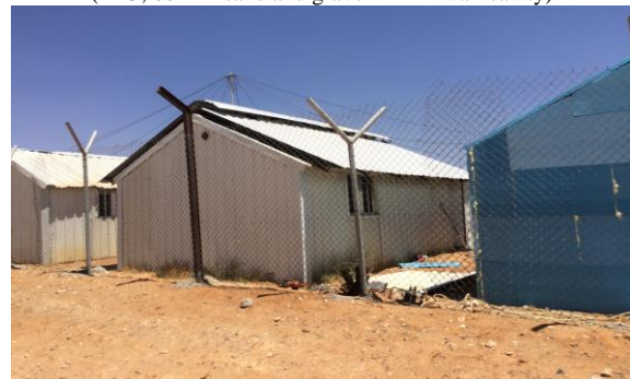
f) Roof shade
